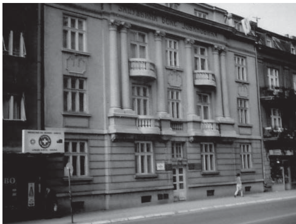
Задужбина Ђоке Јовановића: пескарење фасаде
