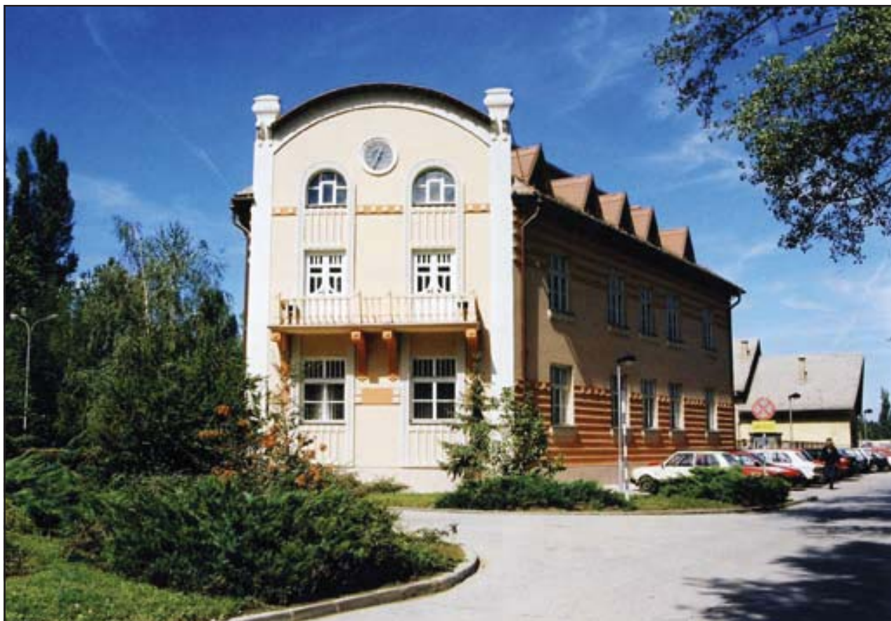
Реконструкција и ревитализација објекта (1910) БФЦ, Конзум, Беоцин Reconstruction and revitalization of the structure (1910) BFC, Konzum, Beočin
